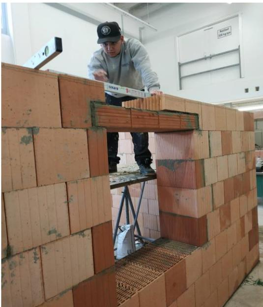
Neben einem Fenster mit dazugehörigem Sturz, wurde ein Schlitz für Installationen angelegt. Das Mauerwerk wird in den folgenden Wochen im Rahmen des Lernfeldunterrichts der Fachklassen 10/11/12 verputzt und anschließend vom Berufsvorbereitungsjahr (BVJ) gestrichen und verflies. Angedacht ist auch eine fachbereichsübergreifende Kooperation mit den Installateuren, die verschiedene Badelemente an die Wand anbringen können.
